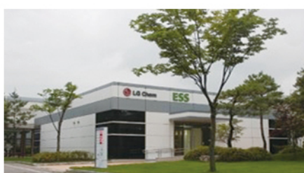
〈LG화학 오창공장 ESS 설계 및 감리용역〉
