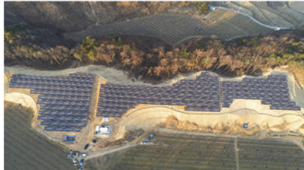
〈영주 하암태양광 발전소〉
