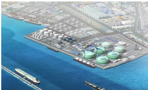
그림5. 울산 북항 LNG 터미널
